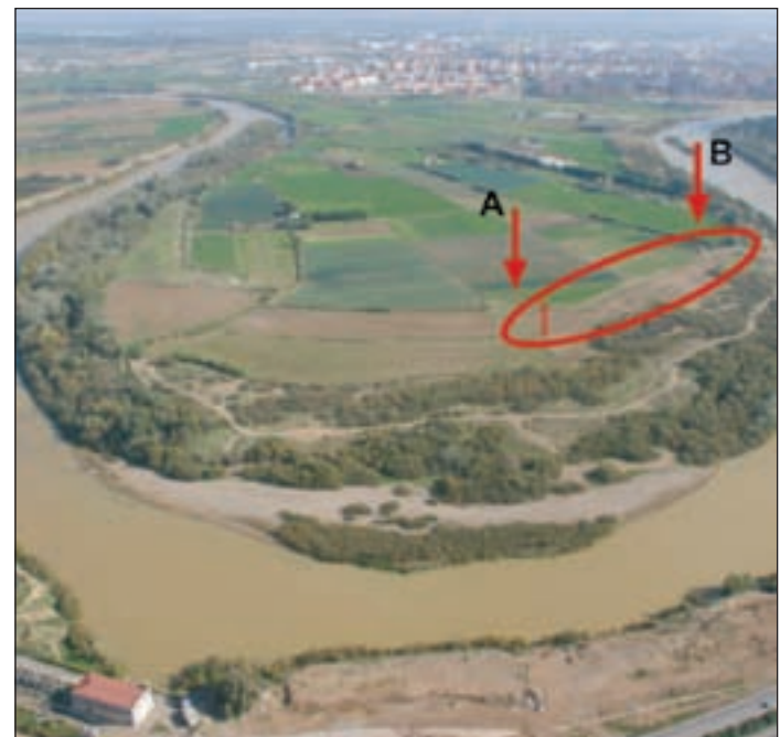
Posición de media luna del segundo puente. En B la obra estaba intacta. Foto: Heraldo de Aragón
