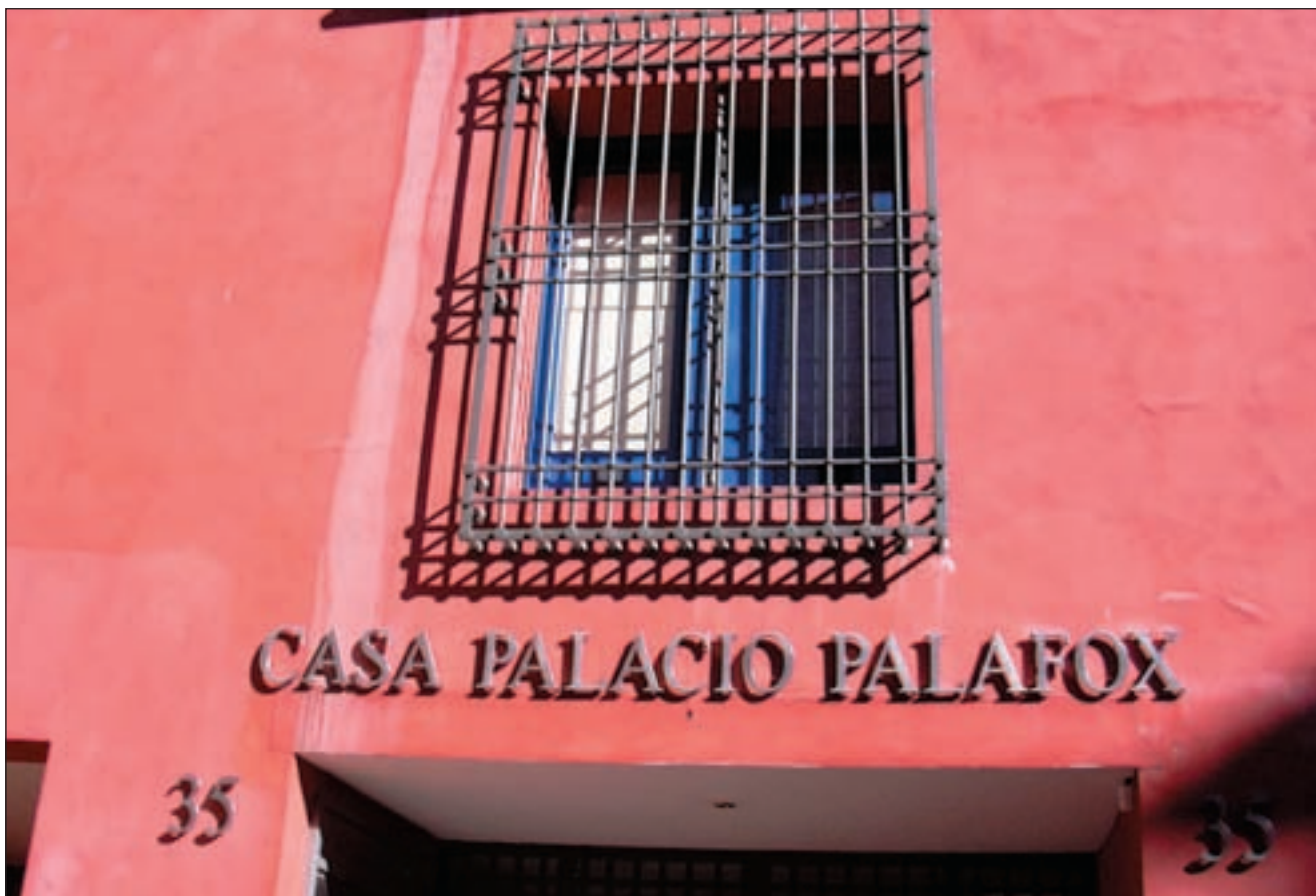
Portal de la Casa-Palacio Palafox, tras la restauración
